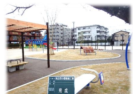
福岡市 南庄西公園整備工事
