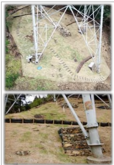
試験施工完了
