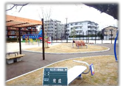
福岡市 南庄西公園整備工事
